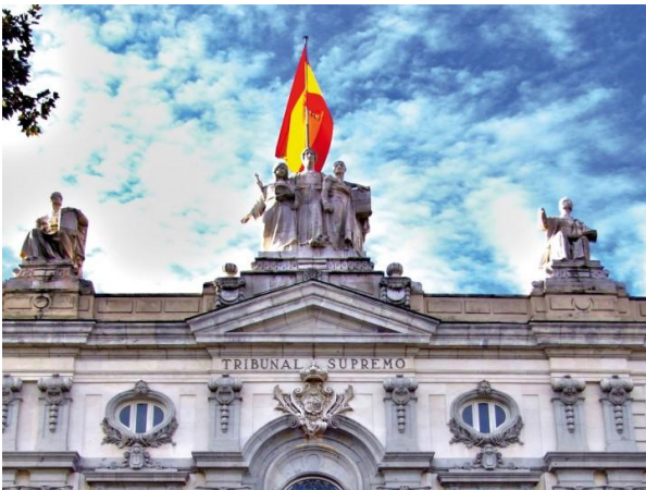
Detalle del frontón de la fachada principal (norte). Foto: biblioteca-fag.blogspot.com
