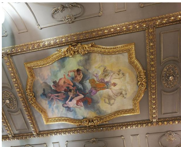
Detalle del techo del Salón de Plenos. Foto León G. Comendador
