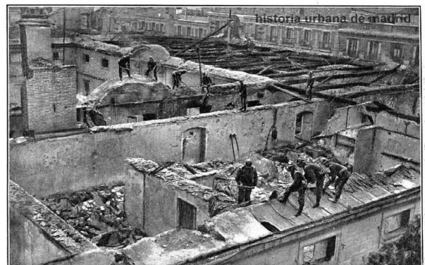
Bomberos observando los daños estructurales en el tejado. Foto: Historia Urbana de Madrid
